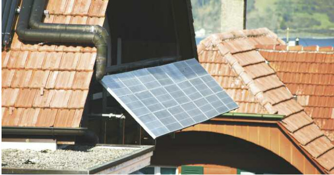
Solaranlage an Fassade
