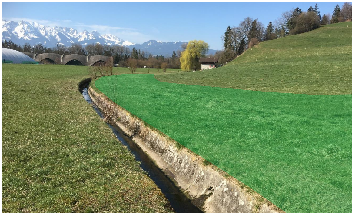
Abbildung 5: Ungefährer Bereich der Bodenaufwertung auf Fläche 11.1 (grün transparente Fläche). Der Chrebsbach soll aus der Halbschale genommen und revitalisiert werden. Das Terrain würde mit dem vor Ort verwerteten Bodenmaterial um ca. 20-30 cm angehoben. Die Grundmodellierung gemäss Ausgangszustand bleibt erhalten.
