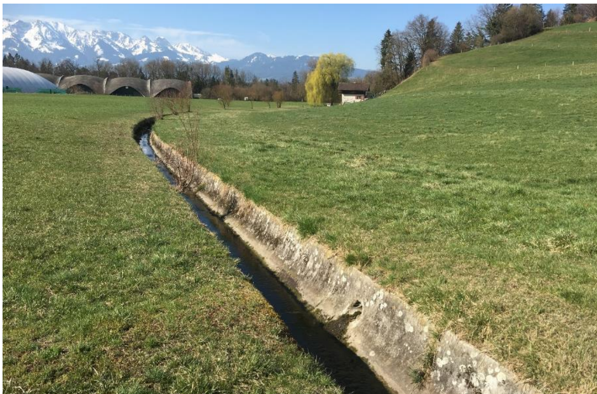
Abbildung 8: Situation im Bereich B3, unterhalb Bäumberg. Chrebsbach in Halbschale. Blick westwärts. Foto: B. Käufeler, 31.03.2019.
