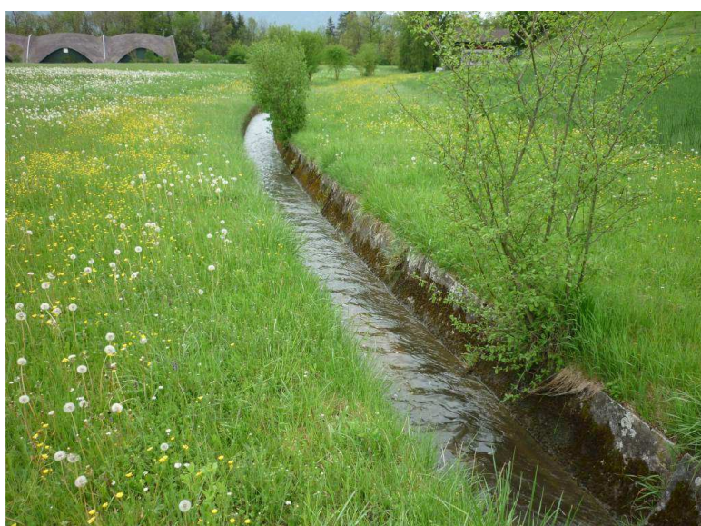
Foto 9 Chrebsbach in Halbschale
