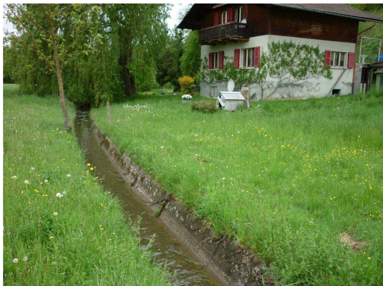
Foto 7 Chrebsbach in Halbschale Blick in Fließrichtung
