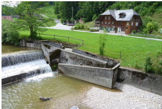
Abbildung 9: Beispiel einer Fischaufstiegsanlage bei einer Sperre (Rötebach in Eggwil).
