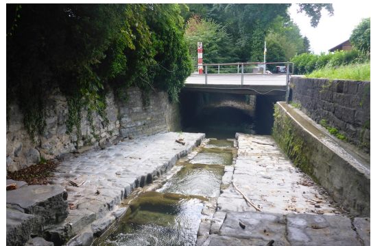
Abbildung 7: Beispiel einer Rampe als Raubett in Hinterbeton mit Niederwasserrinne (Hünibach in Hilterfingen)
