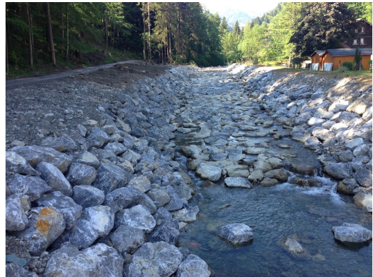
Abbildung 6: Beispiel einer klassischen Blockrampe (kleine Simme in Zweisimmen).
