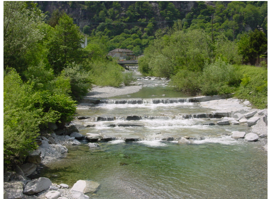
Abbildung 10: Beispiel eines Traversensystems (Ri di Lodrino in Lodrino TI).
