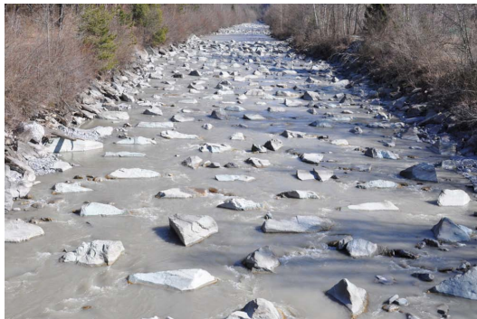
Abbildung 8: Beispiel einer aufgelösten, unstrukturierten Blockrampe (Landquart GR, Blick gegen Fließrichtung; Quelle VAW).
