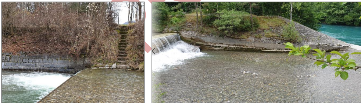
Abb. 9 ZULGGERINNE MIT KIESSOHL E UND SPERREN
