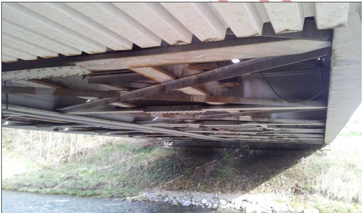
Abb. 12 UNTERSICHT DER EISENBAHNBRÜCKE
