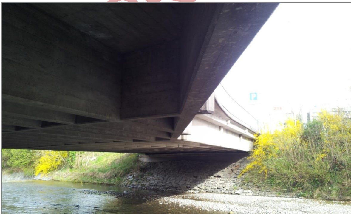
Abb. 11 HOHER KASTENTRÄGER DER BRÜCKE ÜBER DIE BERNSTRASSE
